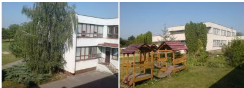
Budova školy v Jarovciach
